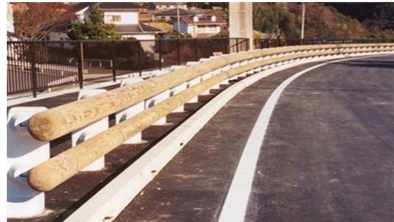
B. コンクリート支柱、スギ(円柱加工)
